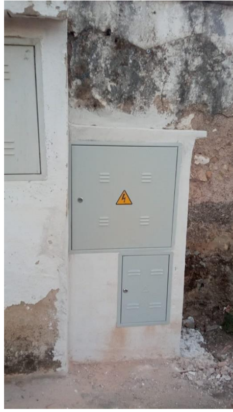
Módulo de Medida Edificio + Módulo de Medida Instalación Fotovoltaica Después
