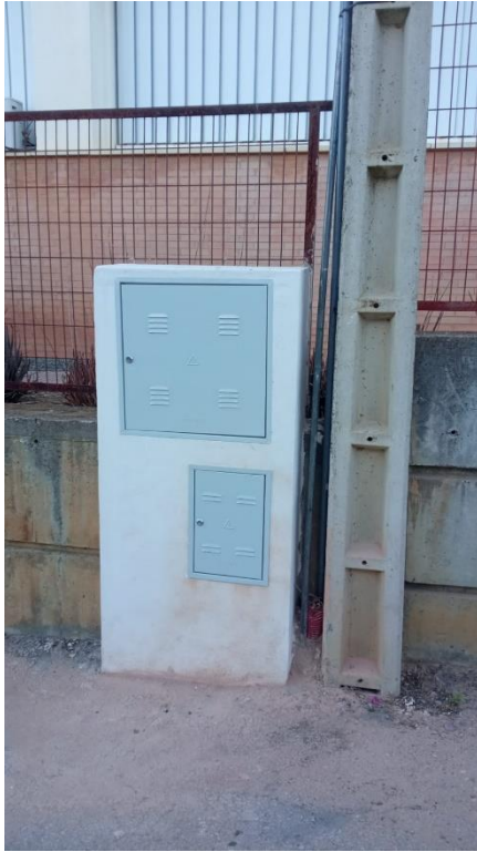
Módulo de Medida Instalación Fotovoltaica Después
