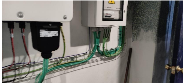
Conexionado Inversor-Cuadro Eléctrico
