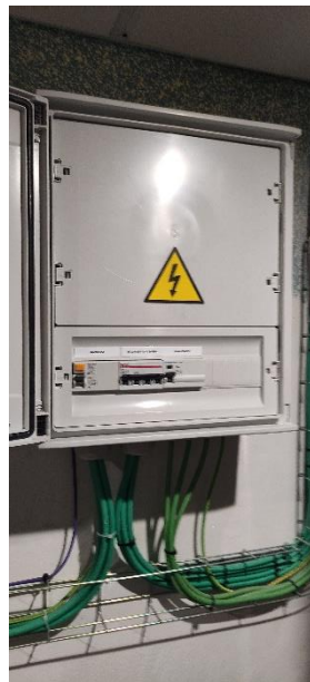
Conexionado Inversor-Cuadro Eléctrico
