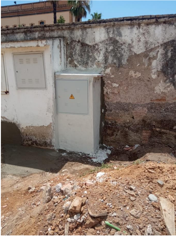
Módulo de Medida Edificio + Módulo de Medida Instalación Fotovoltaica Después
