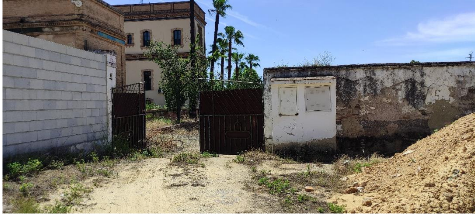
Módulo de Medida Edificio Antes
