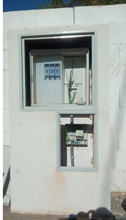
Módulo de Medida Instalación Fotovoltaica Después
