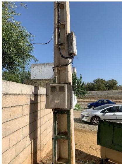
Módulo de Medida Edificio Antes
