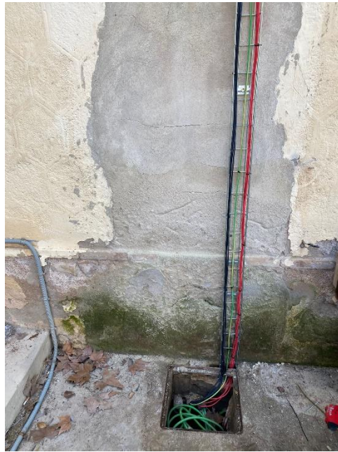
Cableado de conexión paneles fotovoltaicos a inversor
