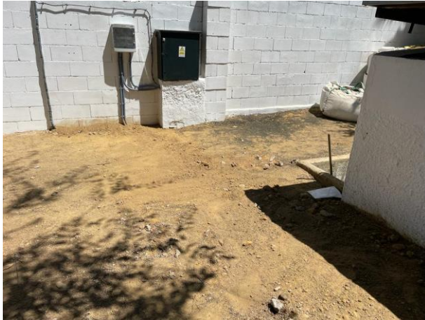
Cuadro Eléctrico Fotovoltaica
