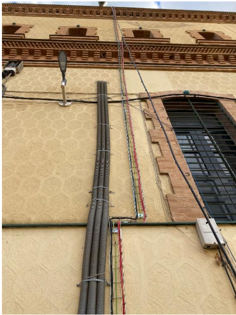
Cableado de conexión paneles fotovoltaicos a inversor
